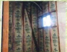
断熱材を張り巡らせます。
