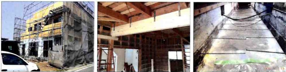
外周りに構造用合板を貼り、耐震補強しました。
