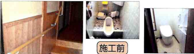
■手すりの取付 廊下、トイレ、浴室、玄関などに、転倒防止や移動補助のための手すりを取付けます。
