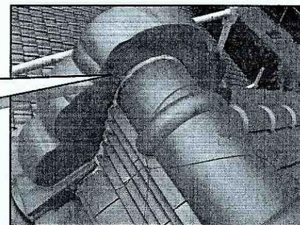
足場の上ったところ鬼瓦のしっくいすべて剥がれていたため、雨漏りしないようにコーキングで処理しました。私達は現場で足場を掛けたら外部すべてを点検します。悪い箇所はお施主様に確認していただいて作業をすすめます。
